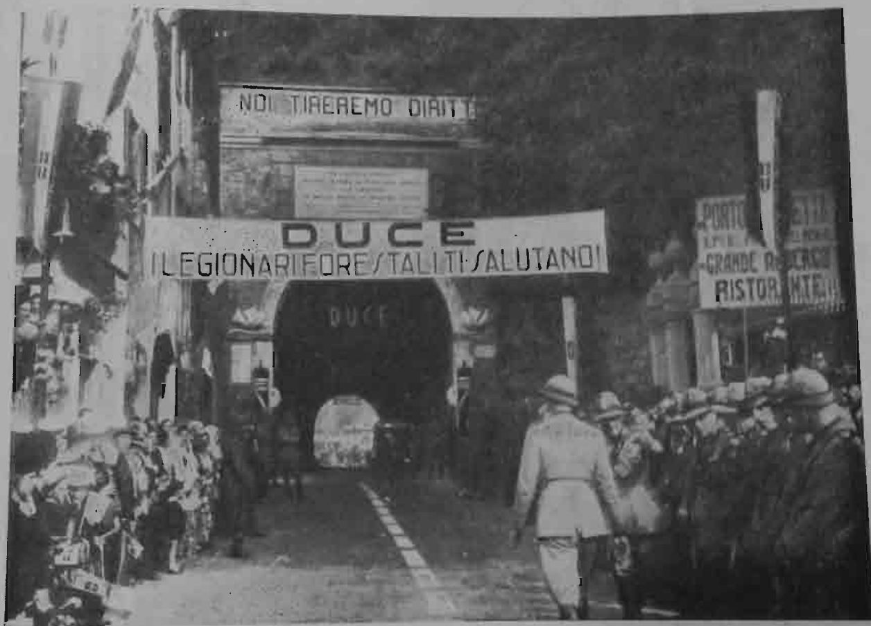
L'ingresso alla galleria di Ruta.
