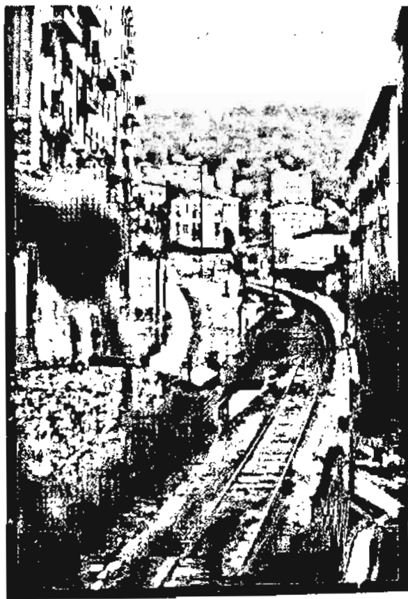
La linea ferroviaria a binario unico, all'inizio del secolo, presso il passaggio a livello che dava in salita Graziani. (Camogli, Archivio fotografico della Civica Biblioteca « N. Cuneo »).
