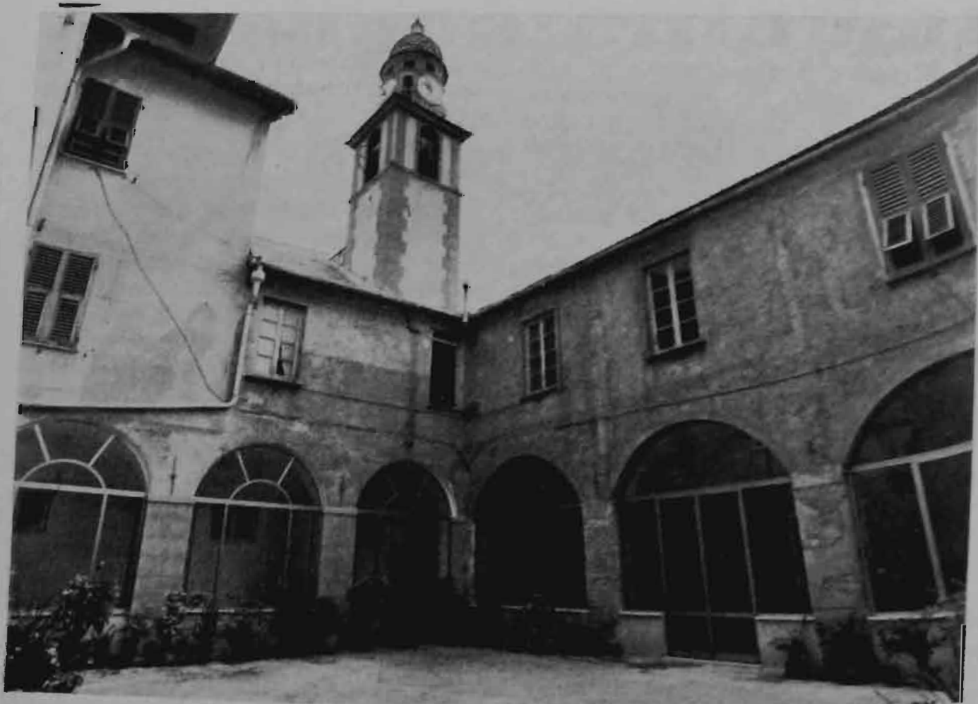
Una visione del chiostro a restauri avanzati
