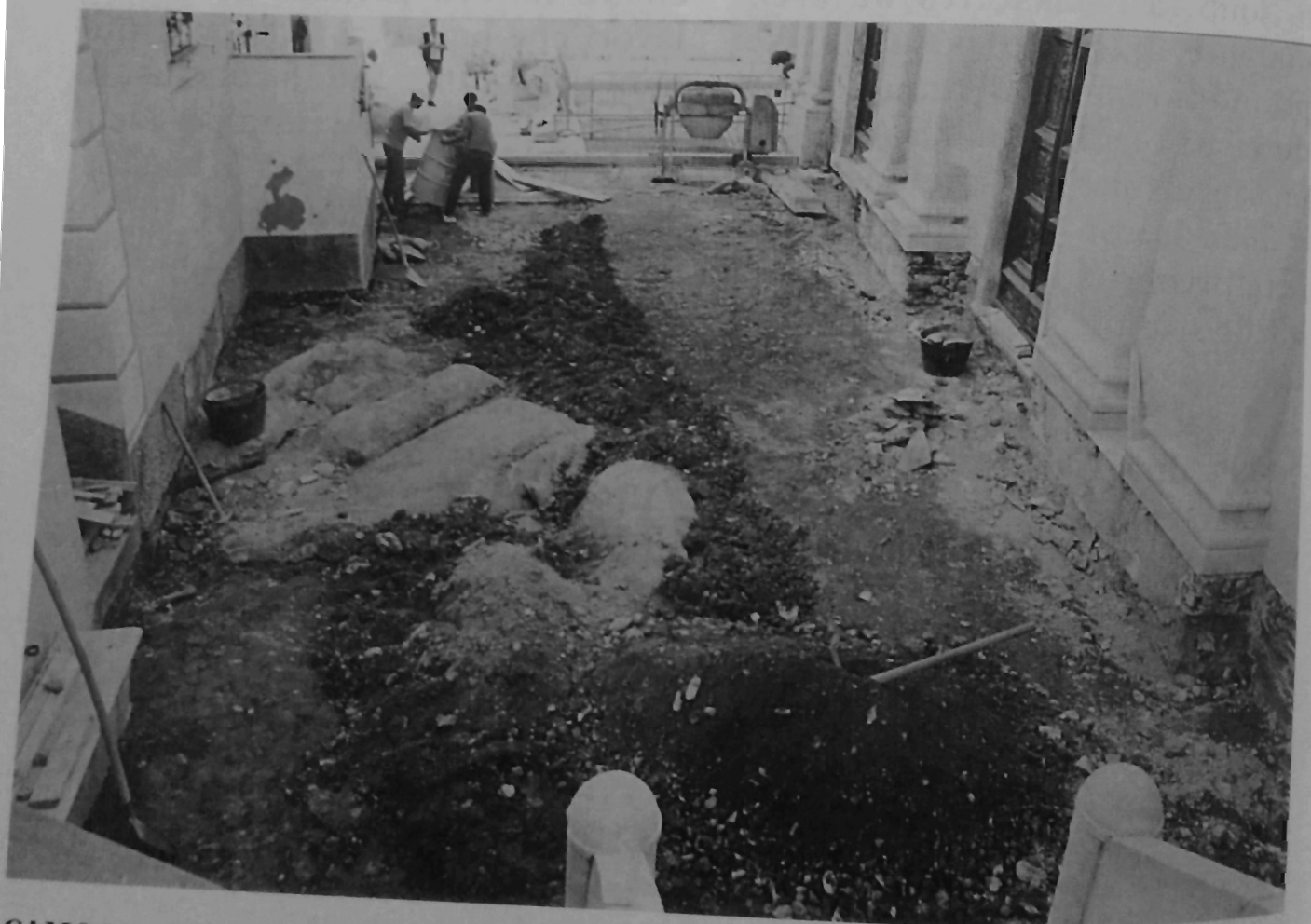
CAMOGGI, settembre 1997: il sagrato della chiesa di S.M. Assunta. Panoramica dei substrati, con, a sinistra, i grossi banchi di roccia emersi tra i resti terrosi sotto l'acciottolato dello scorso secolo (fotografia di Enrico Ferraresi - Camogli).
