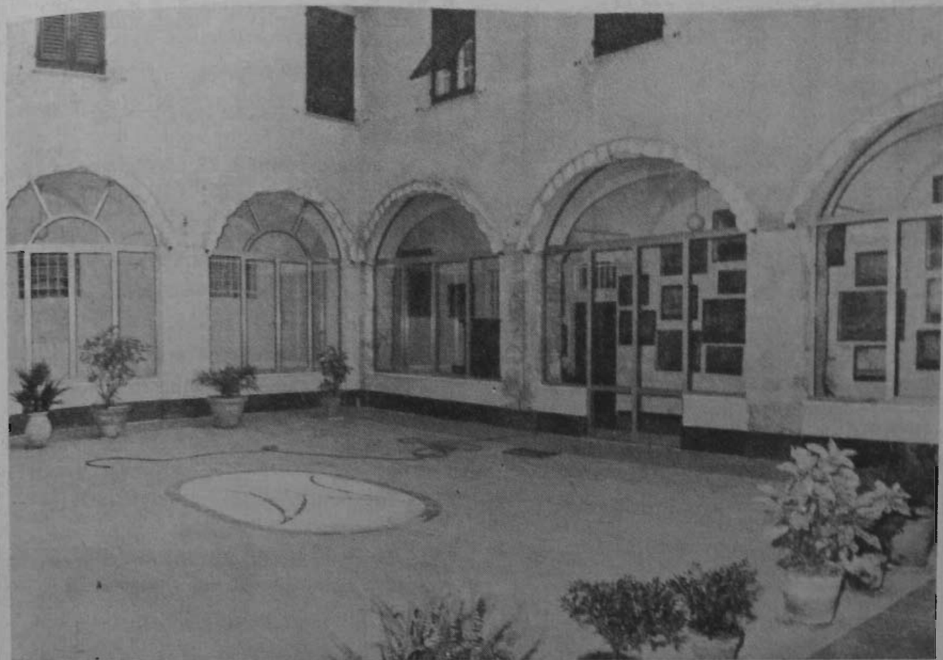
Il Chioostro esterno con la pavimentazione rinnovata in cotto-pietra grigia e ciottoli.
