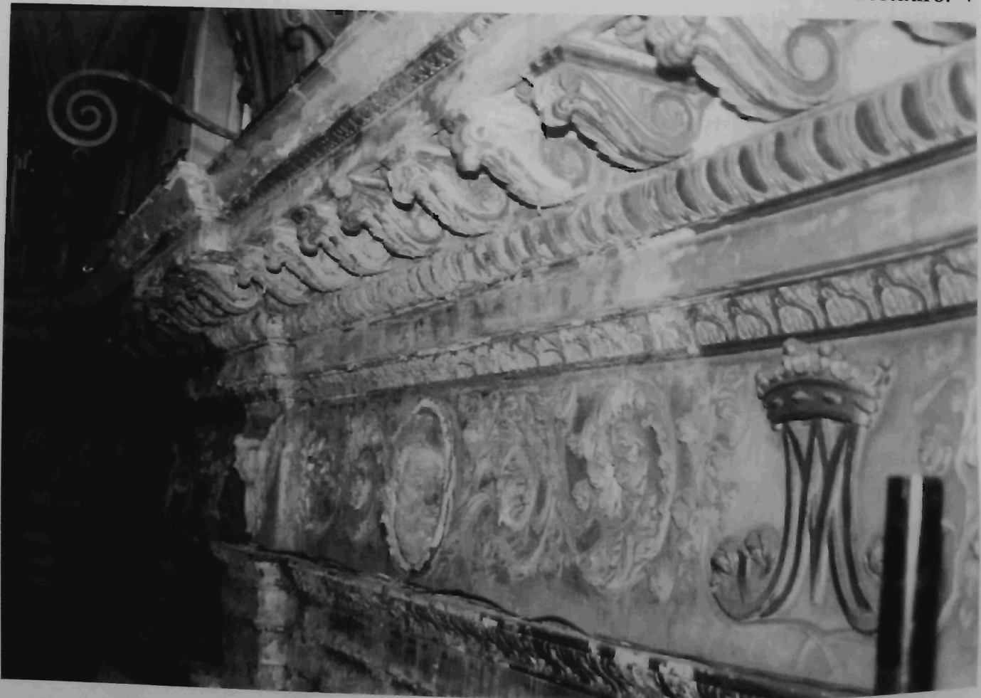
Prima del restauro. ▽
