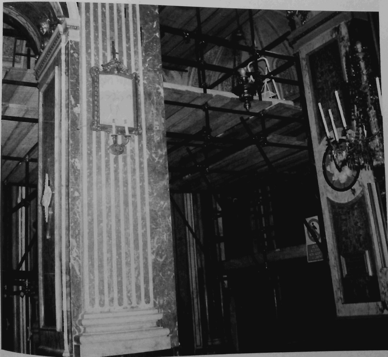
La nostra Chiesa imbavagliata dai ponteggi.
