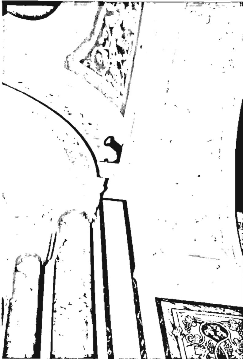
po agli intonaci di asciugare perfettamente, si sono ripresi i colori di fondo con tinte ai silicati; si sono ripristinati il finto marmo policromo, gli stucchi e le modanature con tempere, in marmorino delle lesene, delle colonnine e di tutto l'altare è stato rilucidato a cera.
