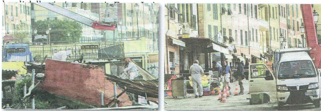
La rimozione del tetto con amianto del locale crollato e la messa in sicurezza al centro del titolare Farfarello con il sindaco Anelli
